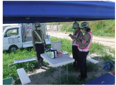
写真 2. 女性社員の建設現場における活躍
