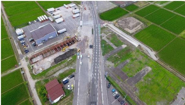
対象工事現場の様子（2021年6月末時点）
