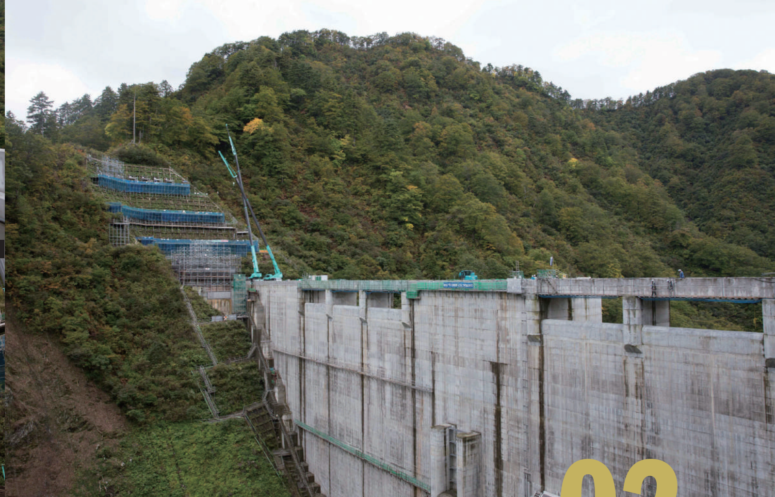
ダム本体と管理棟。安全と環境保全を最優先に工事が進められていく
