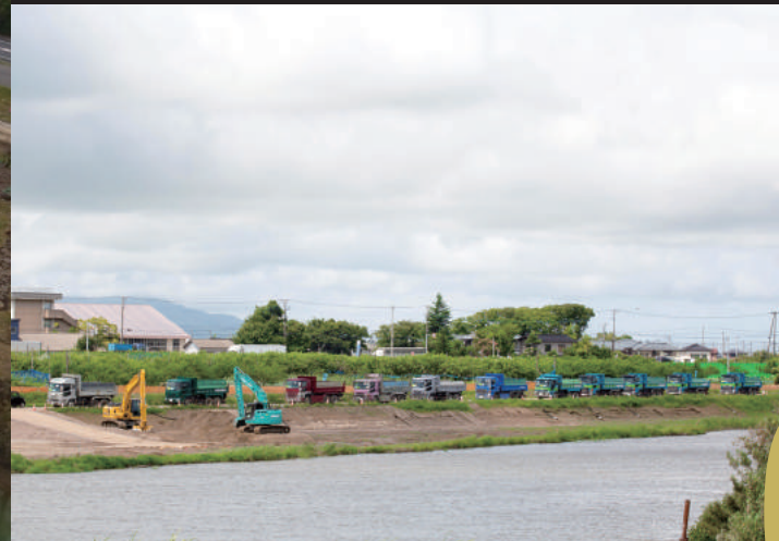
2台の掘削機で土を掘り起こし、30台のダンプトラックで順番に運び出す
