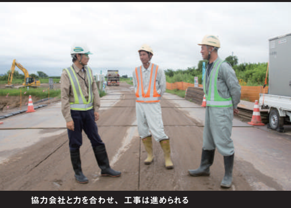
協力会社と力を合わせ、工事は進められる
