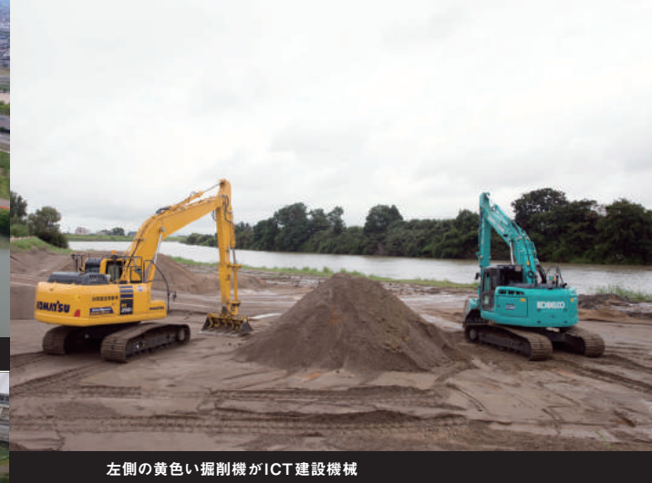
左側の黄色い掘削機がICT建設機械
