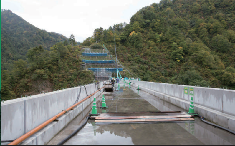
工事中のダムの先に管理棟の現場がある
