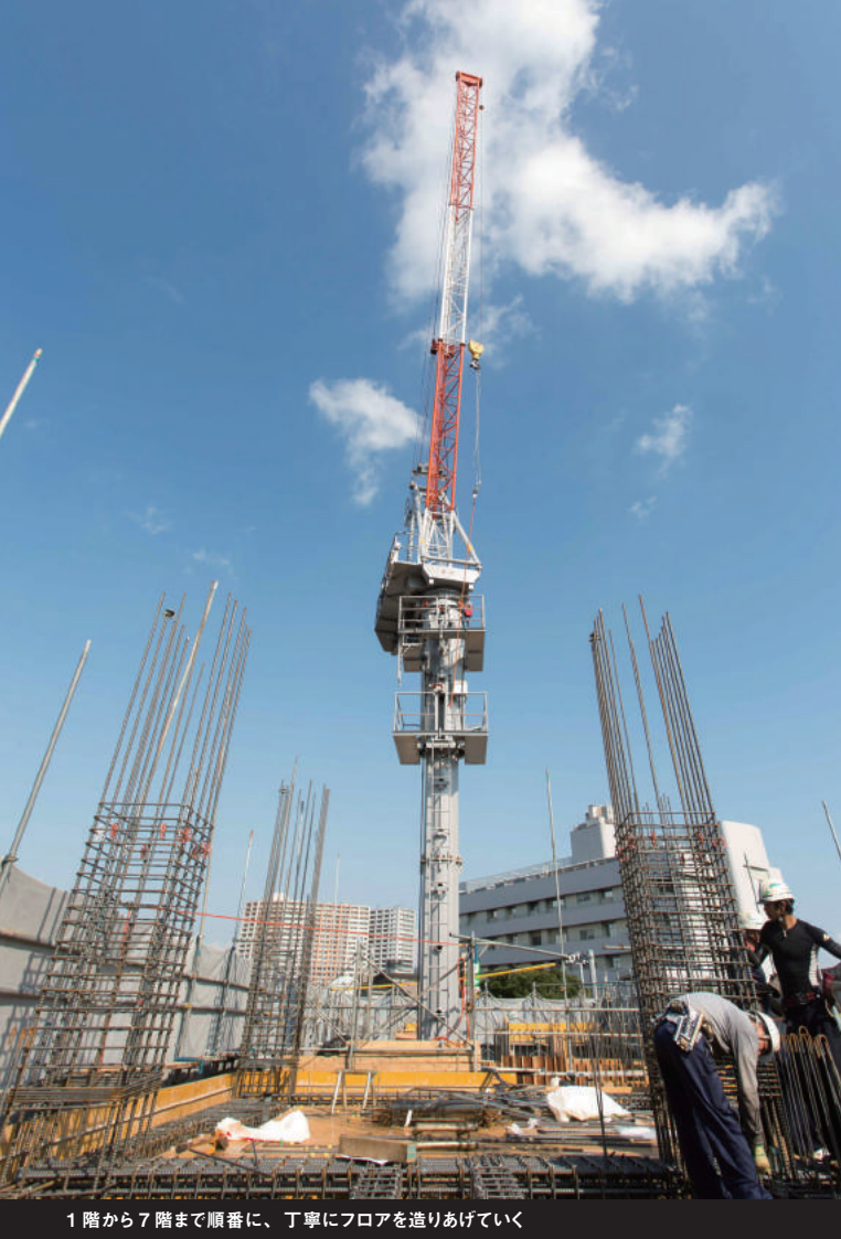
1階から7階まで順番に、丁寧にフロアを造りあげていく
