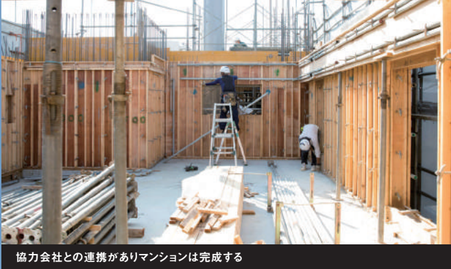
協力会社との連携がありマンションは完成する
