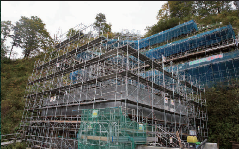
ダム管理棟は山の斜面に造られていく
