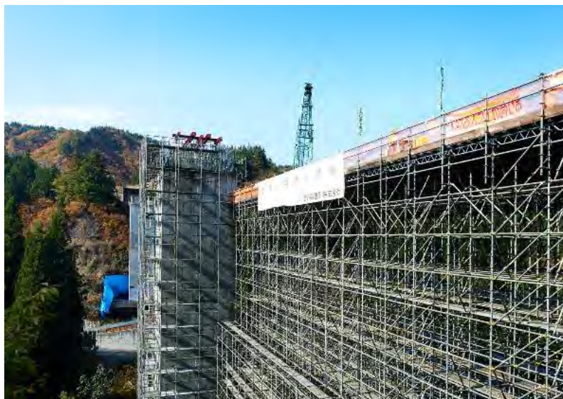
断崖絶壁に、30mの高さの足場をつくる。橋を架けるための準備も一苦労。
