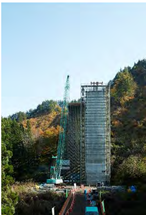
断崖絶壁に、30mの高さの足場をつくる。橋を架けるための準備も一苦労。
