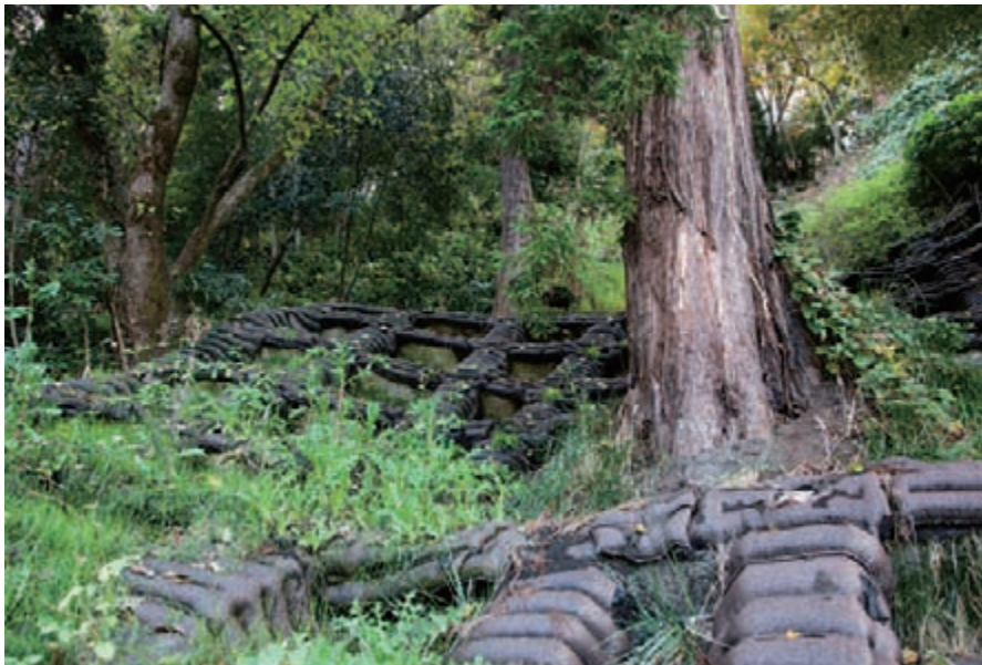
急斜面に施工された緑化。自然な植生と景観を保つため、古木を守りながら施工している。
