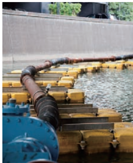
吸い取った土砂はパイプを通して離れた場所にある土運船に送る。
