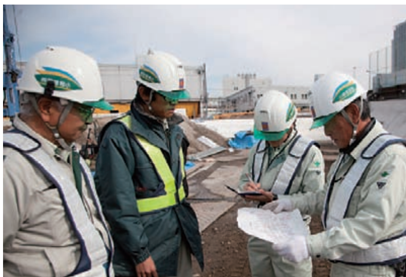
軟弱な地盤と老朽化した地中の水道管など難題の多い現場だけに、慎重な協議を重ねながら工事を進める。
