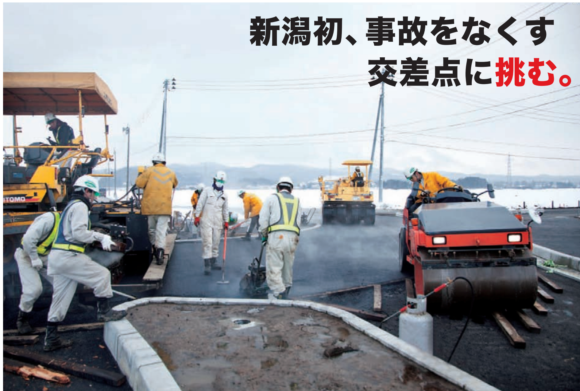
低温のなか、人員と機材、舗道事業部の総力を挙げた作業が続く。
