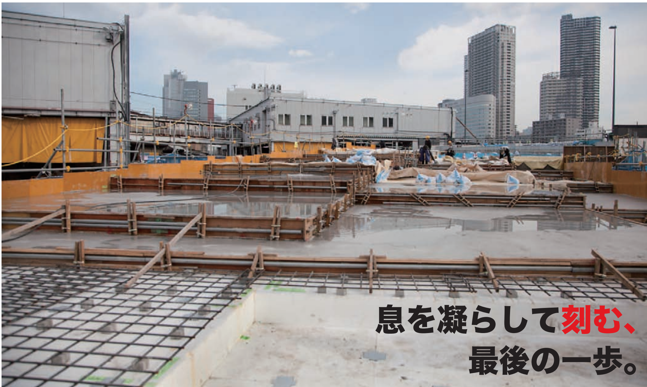
小柳建設は築地大橋へのアプローチ道路を担当。市場移転の物資運搬にはこの道路が使われる。
