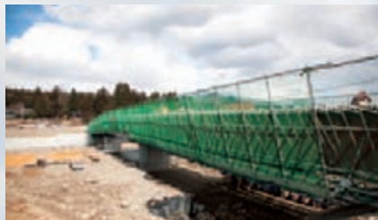
増水を防ぐために川幅を広げ、堤防を新設。写真奥の棚鱗地区と手前の田屋地区を新橋が結ぶ。
