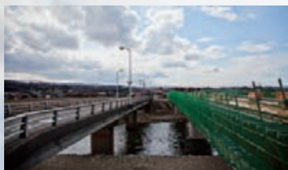
右手の橋が完成すると左手の現橋は取り壊され、復旧工事が終わる。
