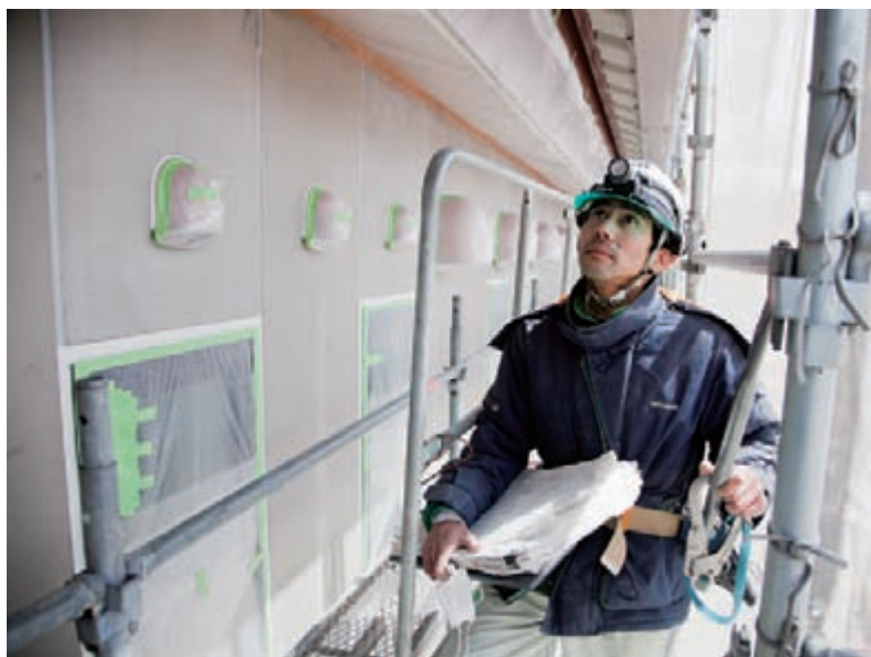
分厚い設計図の束を持ちながら現場を歩きまわって仕上げを確認する。
