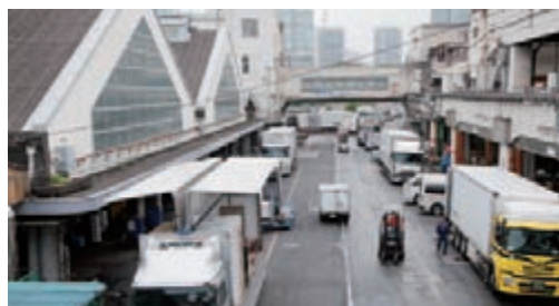
東京の台所・築地市場は間もなく豊洲に移るが、その移転ルート整備を小柳建設が担う。
