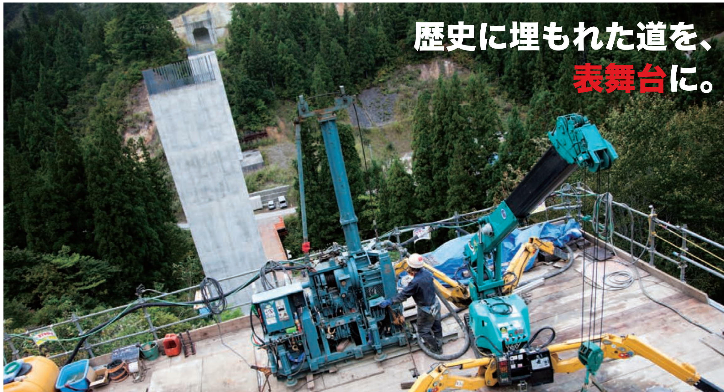
小柳建設の施工担当の橋台より、現場全体を臨む。最終的には谷の反対側のトンネルまで橋で結ばれる。
