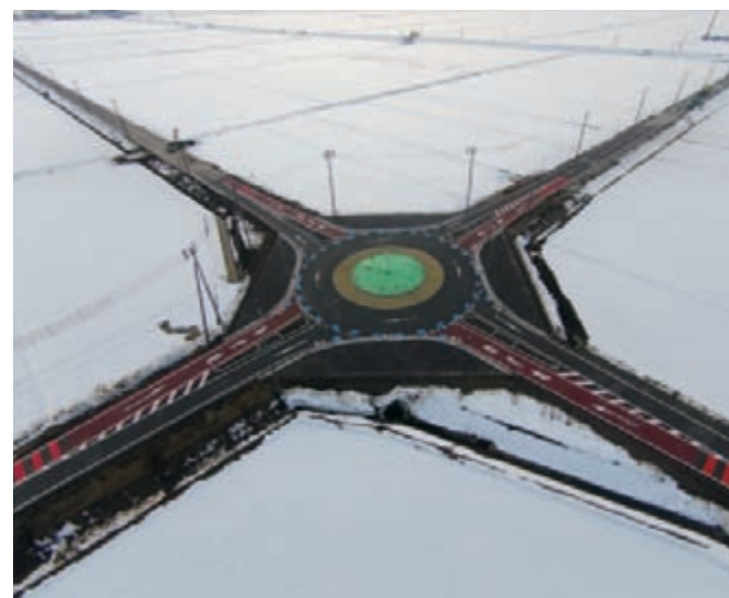
ラウンドアバウト「田上あじさい交差点」は、安全性向上だけでなく観光の起爆剤としての期待も高い。
