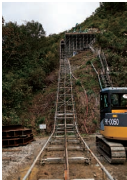
急峻な斜面上にある作業現場までトロッキを設置、作業効率が格段に向上した。
