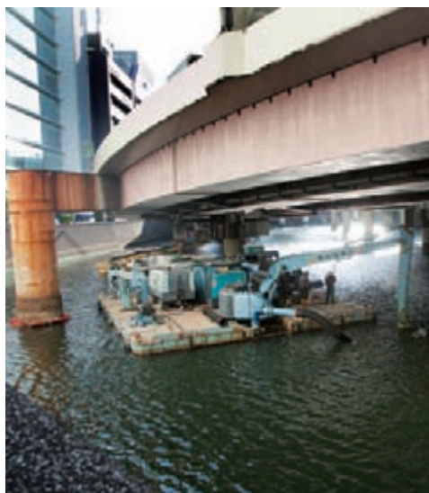
川面と高架に挟まれた狭い空間でも小柳建設の浚渫船なら大丈夫である。
