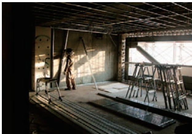
改修工事と耐震補強工事が同時進行する現場の工程管理は複雑だ。
