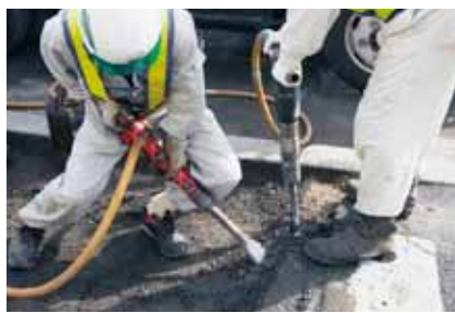
ダイヤモンドと同じ硬度の刃で路面を削りとる。
