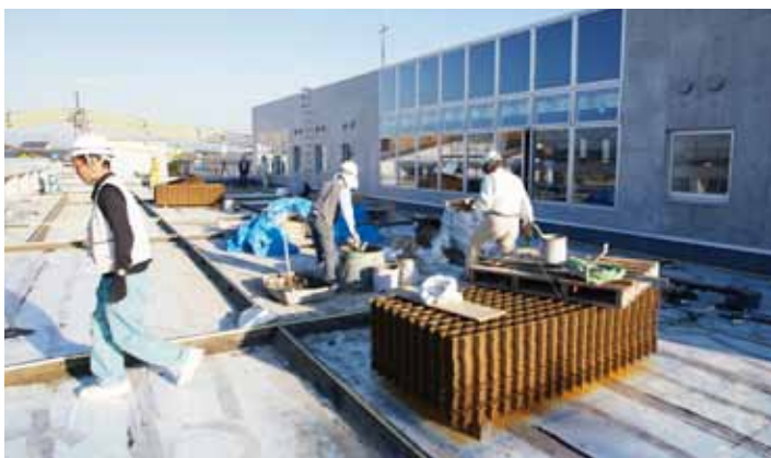
屋上は洪水時の避難場所にもなるため、鉄筋コンクリートの打設にも力が入る。
