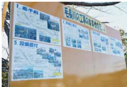
川沿いを歩く人たちが見えやすい位置に工事状況を掲示。
