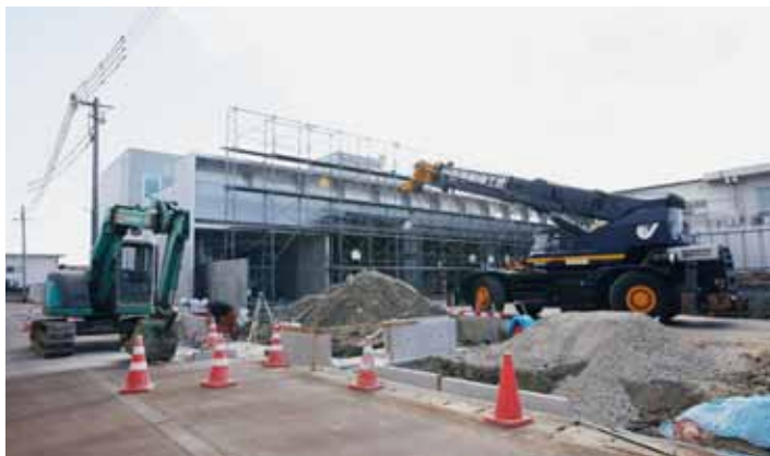
高度な施工力が試される「鉄筋コンクリート打ち放し仕上げ」の壁面。
