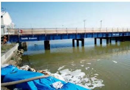
工事のために架けた仮橋。
