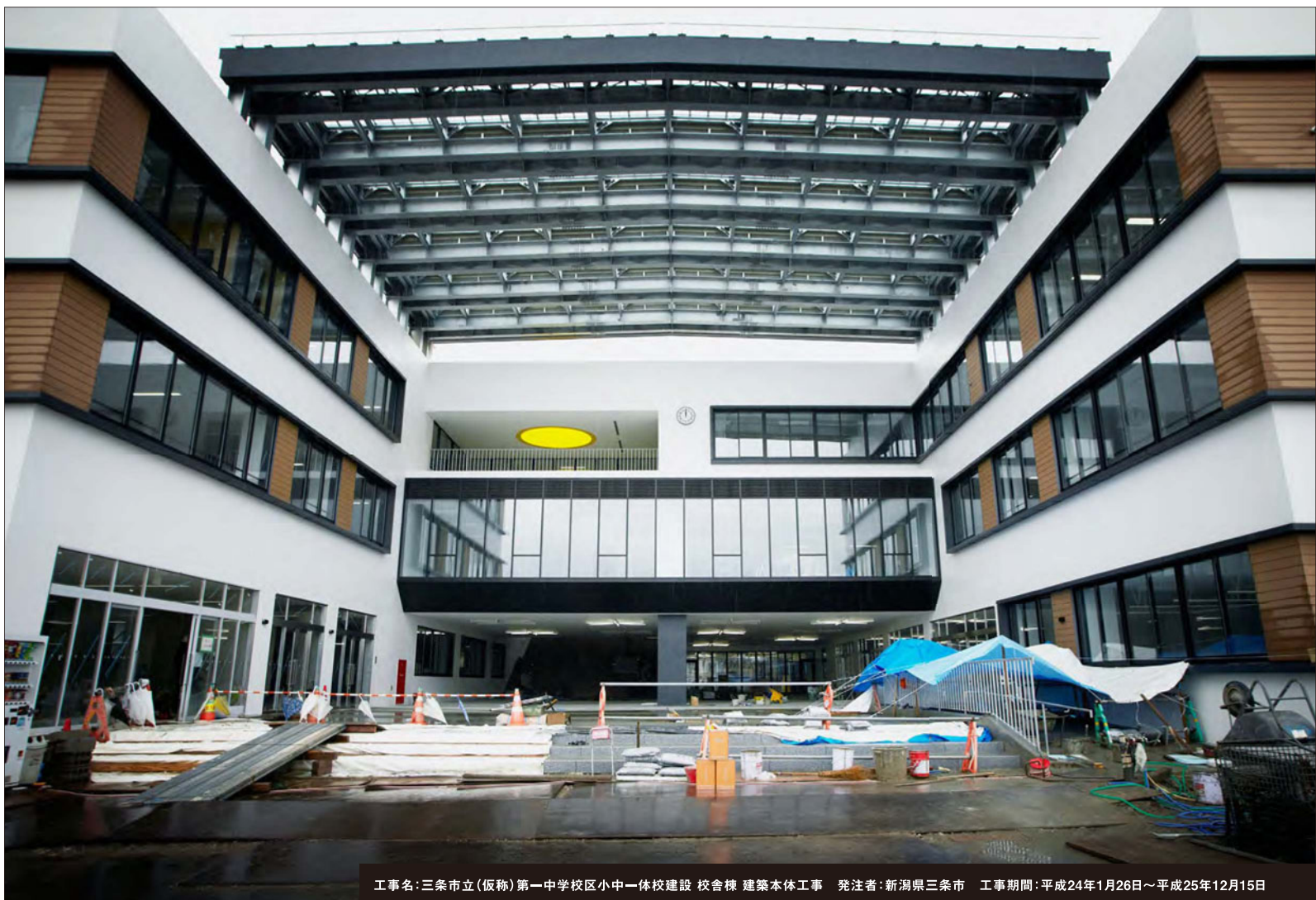
工事名:三条市立(仮称)第一中学校区小中一体校建設 校舎棟 建築本体工事 発注者:新潟県三条市 工事期間:平成24年1月26日～平成25年12月15日
