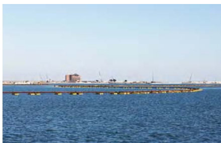
全長1.5キロのパイプライン。ここを泥が通り岸まで運ばれる。
