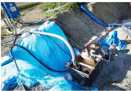
地下水を吸い上げるウエルポイント。
