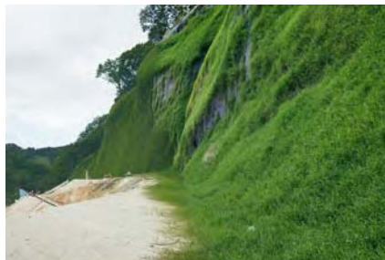
砕いた枝や根を法面に吹付け、緑化。 小柳建設の独自の技術が活かされている。
