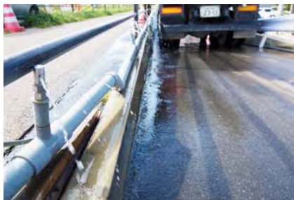
川の水を引き、トラックの土で道が汚れないよう出口に工夫を。
