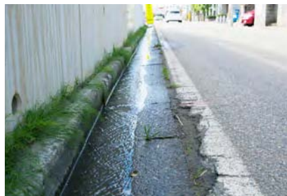
国道に水が流れ、汚れることがないように道の端を水が通る。
