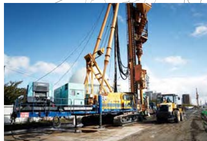
砂杭を打つサンドコンパクションバイル工法。近くにいても本当に静か。
