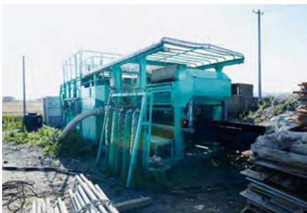
現場では工事が出た排水を浄化し、川へ戻す大型機器も準備。
