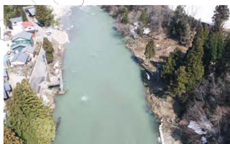
工事前。ほんの一部を残して、流されてしまった吊り橋。
