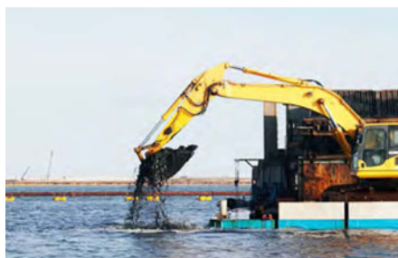
水底の土砂を掘削しパイプラインで空気圧送する。
