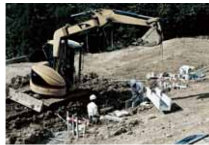
広大な斜面を地道に復旧していく。
