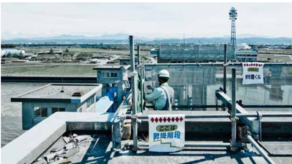
長年劣化によって損傷した部分の改修工事が行われている蒲原大堰・中ノ口川水門路。欠損した壁部の補修及び防水を行う工事は、建築の技術も要する。
