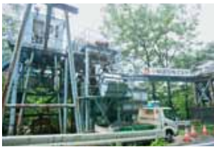
③ 落ち葉や英雑物を取り除き、浚渫物を脱水機へ。（ブースターポンプ）
