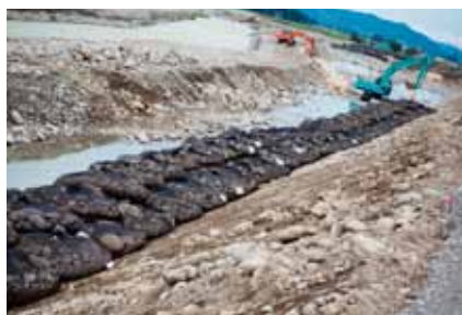
堤防を補強する袋詰玉石は1880個用意。
