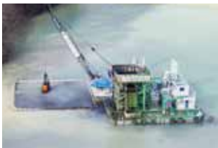
① 浚渫状況。（グラブ浚渫船「草津」、土砂圧送船）
