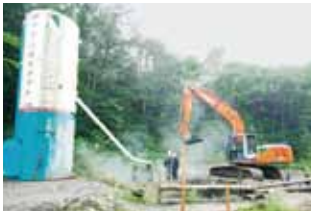
⑥ 土質改良（セメント固化）を行う。
