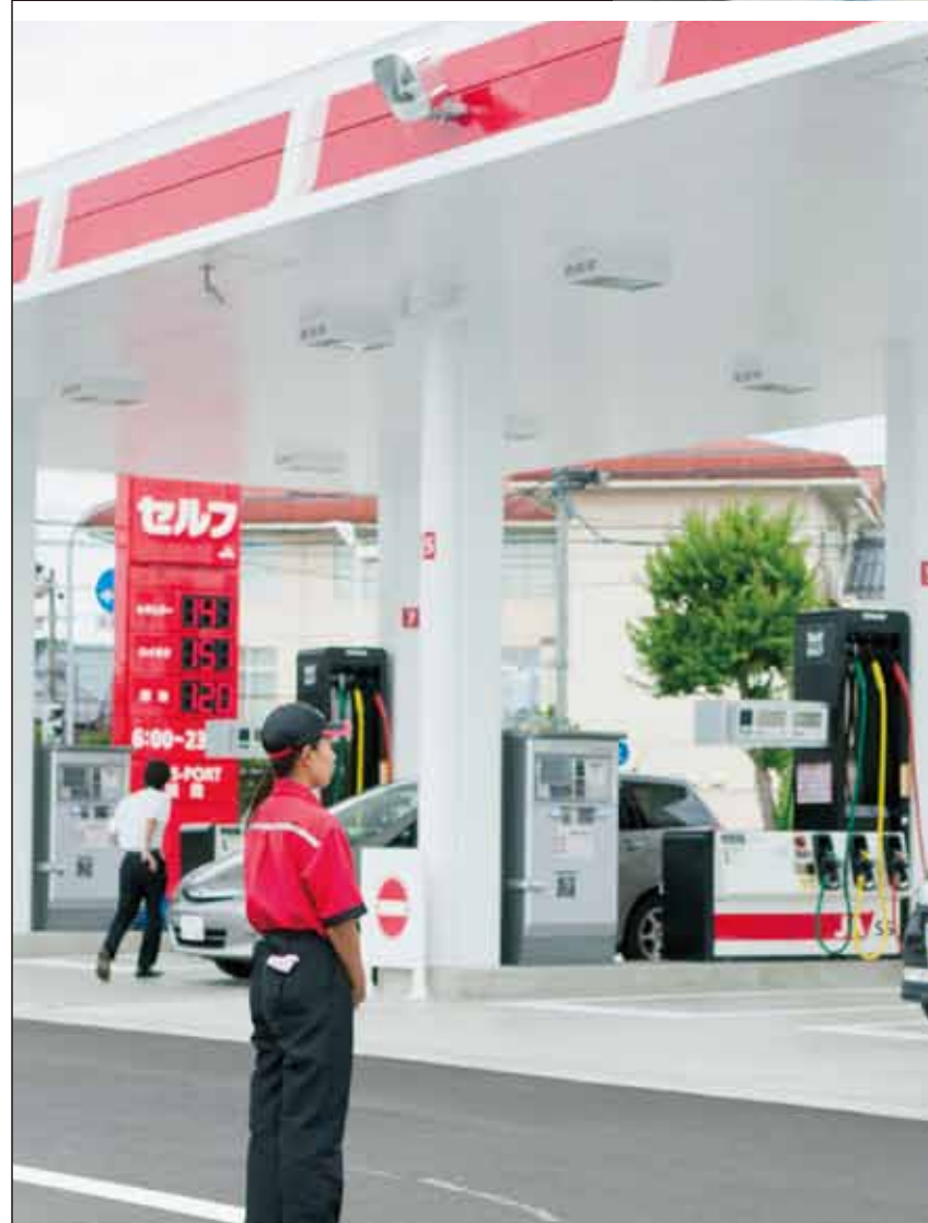
JASS-PORT加茂・建設工事（2011.4.18～7.11）新潟県加茂市
