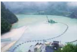
② 手前のパイプから浚渫物を圧送。
