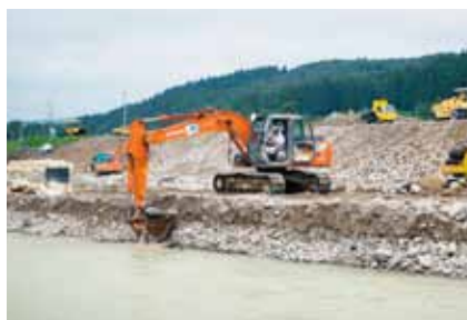
堤防は31000m 3 の現地土砂を利用。
