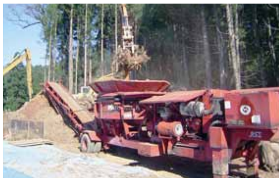
① 工事の現場で出た幹・枝・根株を碎き、チップ加工します。
