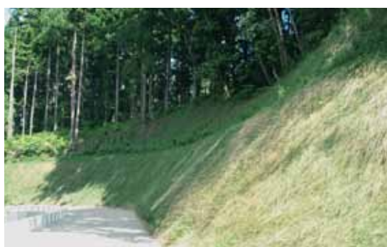
④ 吹き付け後、徐々に植物が発生します。
