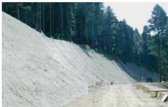
② 緑化基礎工（手前茶色部分）を行い、ミキシングホッパーでチップを均一に攪拌しながら、モルタルコンクリート吹付機に安定供給します。
