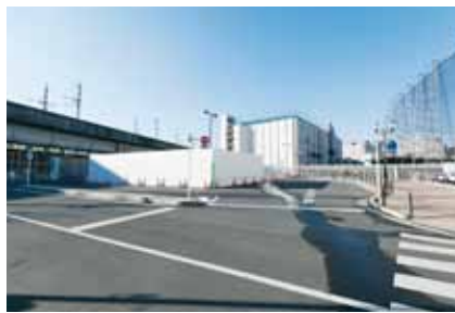
作業ヤードのある場所は、もともとは駅前のタクシー用ロータリーだった。
