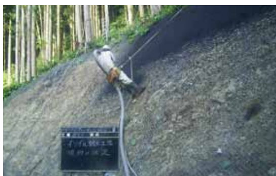
③ モルタルコンクリート吹付機で材料をさらに混合し、吹きつけます。
